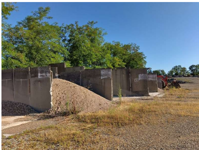
Zone de transit des matériaux Source : Artifex
