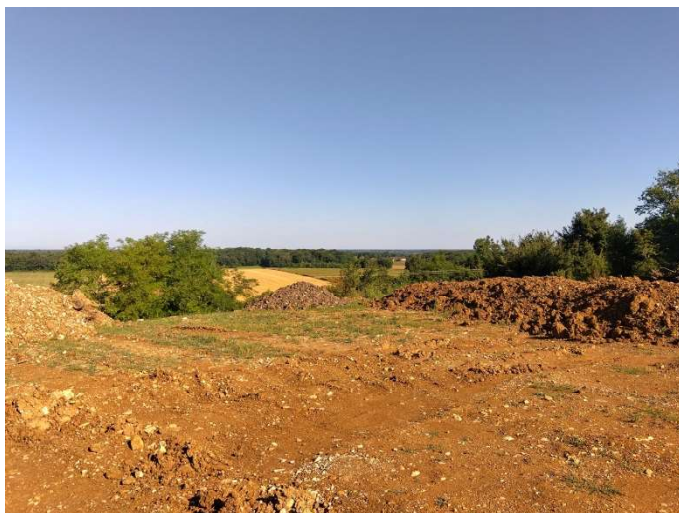
Plateforme sommitale remblayée
